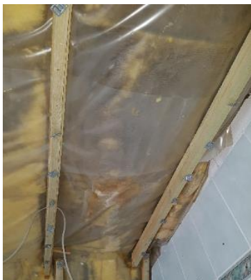
stehendes Wasser auf der Dampfbremse im Bad
