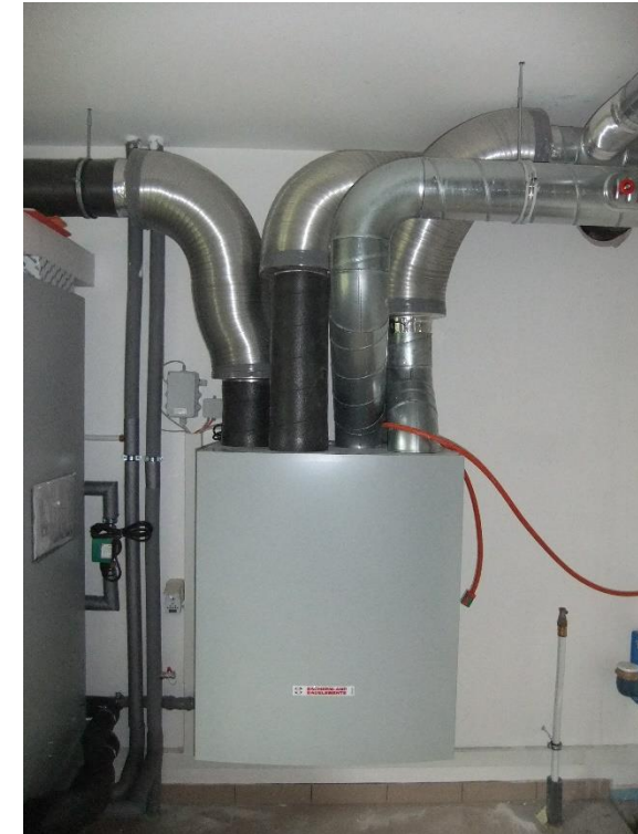
Abb. Zentrale Lüftungsgerät mit Wärmerückgewinnung
