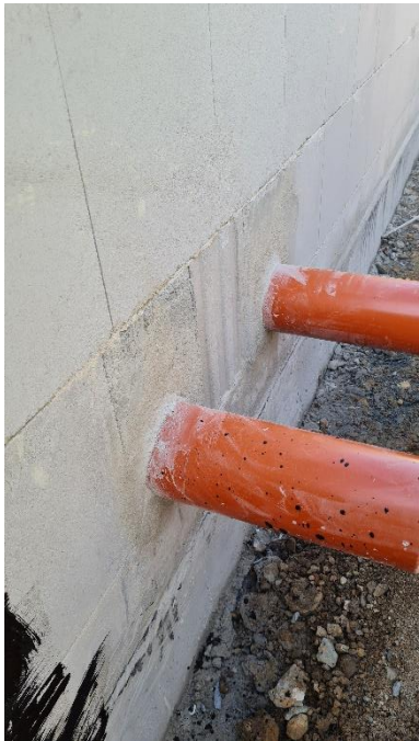
Abb. Abdichtung von Rohrleitungen mit EPDM Manschetten in die Außenabdichtung mit Bitumendickbeschichtung
