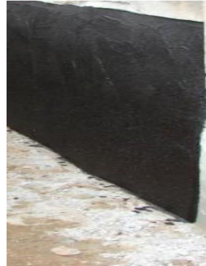
Abb. Beispielhafte Sanierungsplanung einer nachträglichen wannenartigen Abdichtungskonstruktion an einem denkmalgeschützten Gebäude (links), nachträglich ausgeführte Vertikalabdichtung aus PMBC an einem denkmalgeschützten Gebäude (rechts), Quelle: GB1 Ingenieure
