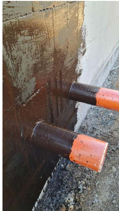
Abb. Abdichtung von Rohrleitungen mit EPDM Manschetten in die Außenabdichtung mit Bitumendickbeschichtung
