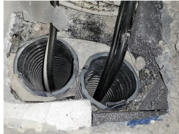
Abb. Radoneintrittspfade an unzureichend abgedichteten Leitungsdurchführungen und Leerrohren
