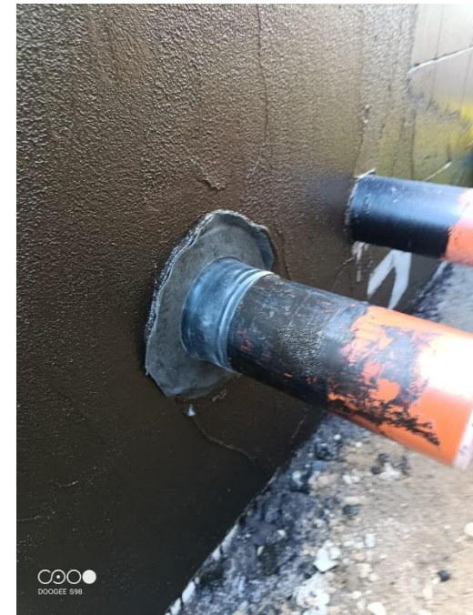
Abb. Abdichtung von Rohrleitungen mit EPDM Manschetten in die Außenabdichtung mit Bitumendickbeschichtung
