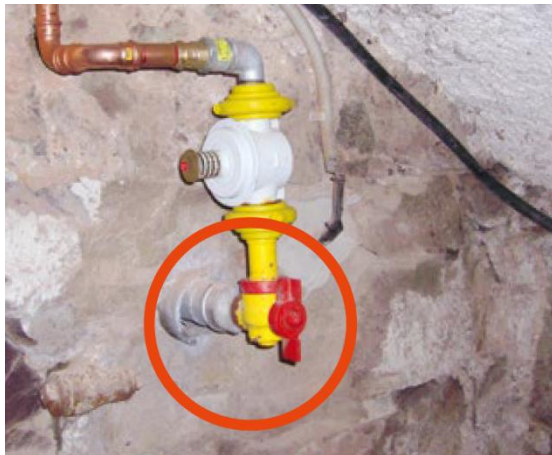
Abb. Radoneintrittspfade an unzureichend abgedichteten Leitungsdurchführungen und Leerrohren
