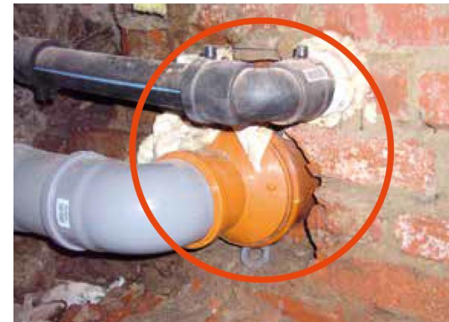
Abb. Radoneintrittspfade an unzureichend abgedichteten Leitungsdurchführungen und Leerrohren
