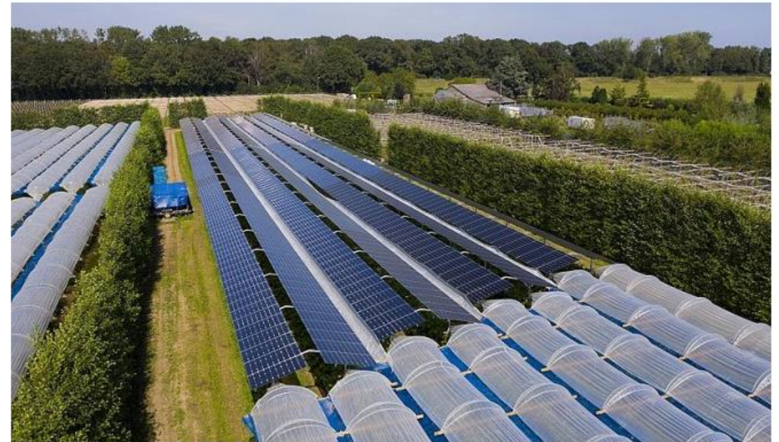
Auf einem Teil der Himbeermfarm werden noch konventionelle Folientunnel zum Schutz der Beeren genutzt. Aufgrund der guten Erfahrungen soll nun die gesamte Plantage mit Solarmodulen abgedeckt werden, dies entspricht einer Anlagengröße von 3 Megawatt. (Bildquelle: BayWa r.e)
