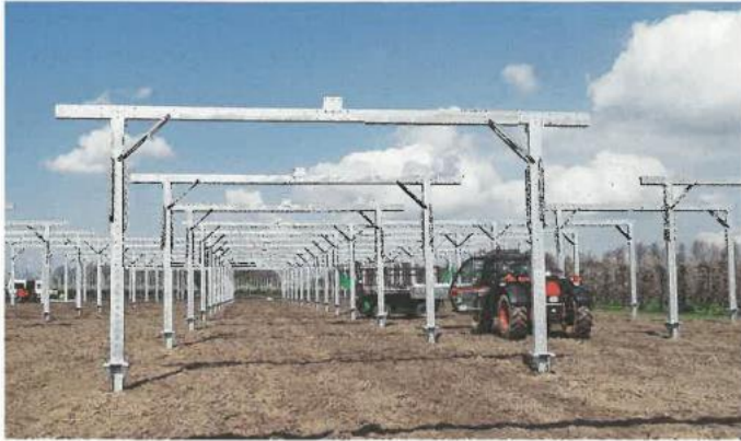
Am 12. April wurde mit dem Setzen der Pfeiler begonnen, die die Module demnächst tragen sollen. Anfang Mai sollen die Baumaßnahmen beendet sein.
