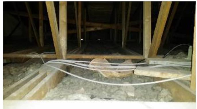
Mangelhaft gedämmte Decke über der Turnhalle
