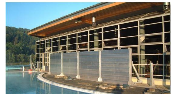
Abschirmung von Einzelgebäuden mit mobilen Hochwasserschutzsystemen.
