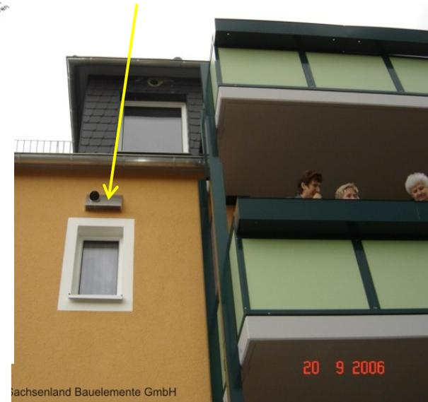
Lüftung mit Wärmerückübertragung
