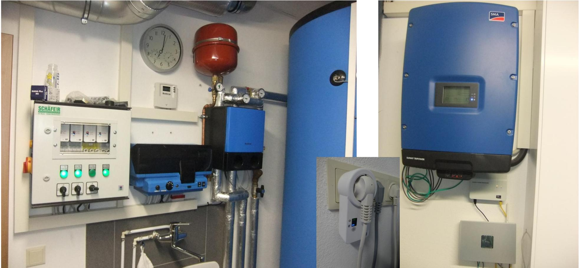
Heizungssteuerung (links: Schaltkasten mit Funksteckdosen für Heizpatronen und WW-Bereitung; Mitte: Kesselsteuerung für Puffer; rechts: Pumpengruppe für wassergeführten Kamin)
