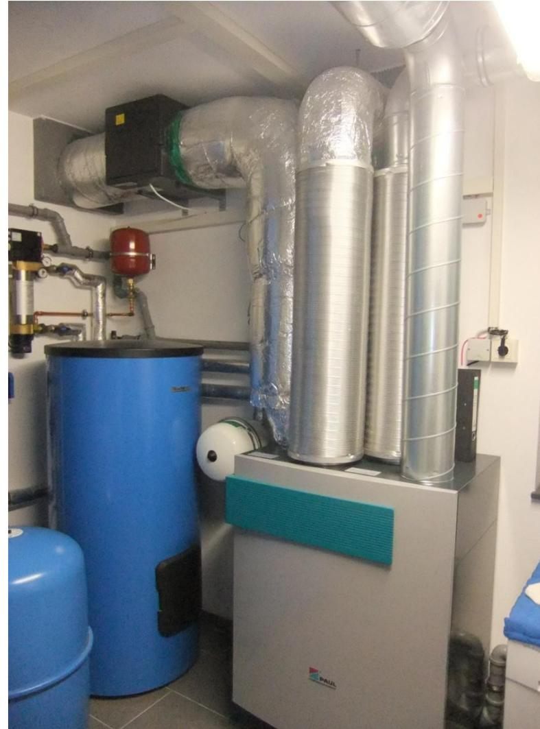
Lüftungsgerät mit Wärmerückgewinnung und Frischluftvorerwärmung ab ca.  $-1\text{ }^{\circ}\text{C}$
