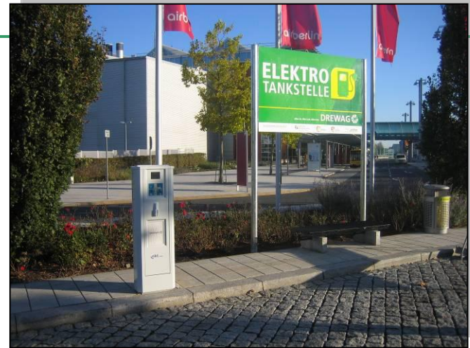
Ladesäule am Flughafen Dresden
